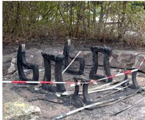
Spielplatz Köhlerweg Schaden: ca. 3.200 EUR
